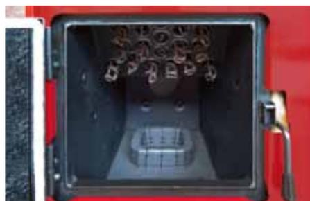
Fascio tubiero con turbulatori munito di dispositivo a bilancieri per la pulizia dello scambiatore
