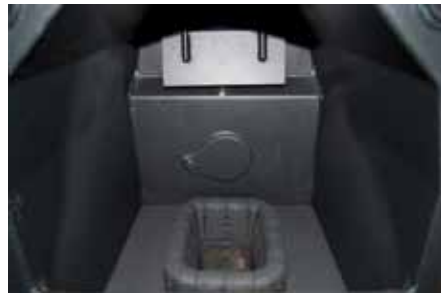
Camera di combustione
