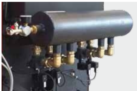
Pulizia pneumatica fascio tubiere
